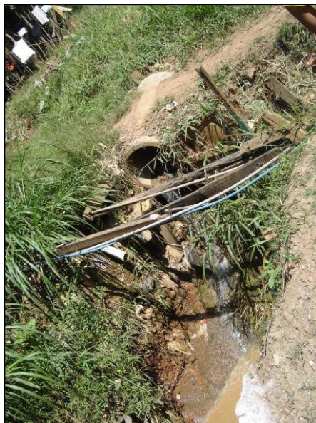
Figura 14. Lançamento de ramal coletor de esgotos em córrego próximo a residências.
