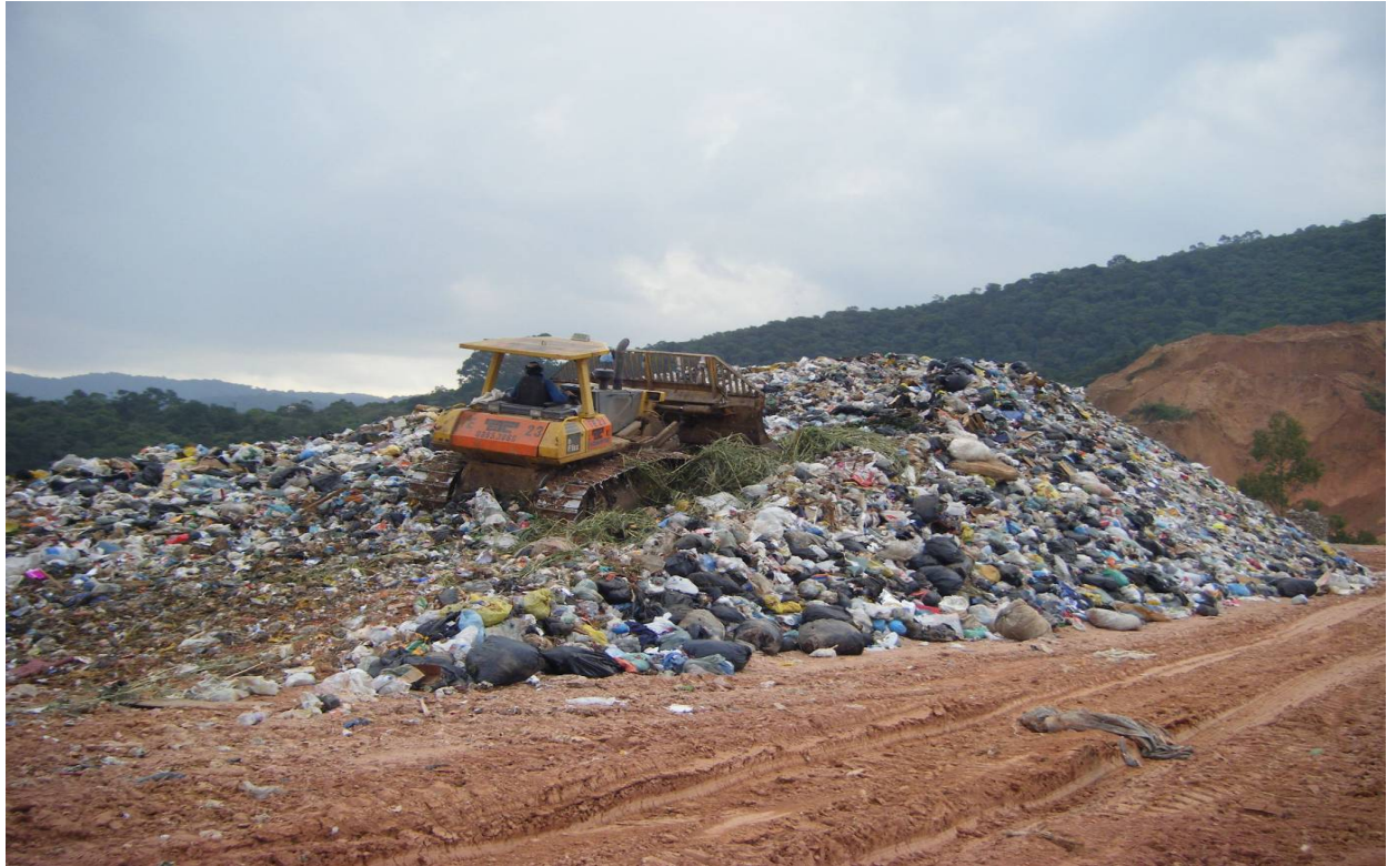
Foto 7 – Trator compactando o volume do lixo. Fonte: Arantes, F., 2008.
