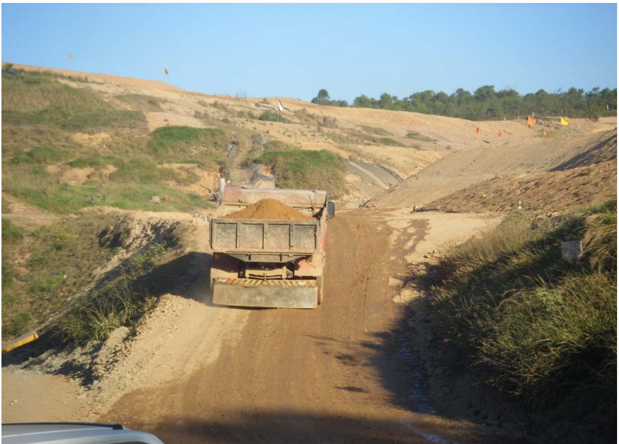
Foto 20 – Caminhão com argila de fora do terreno do aterro. Fonte: Arantes, F., 2008.
