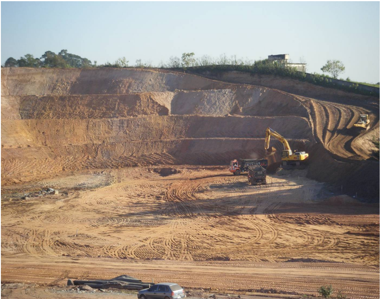
Foto 17 – Área de ampliação e os taludes construídos. Fonte: Arantes, F., 2008.
