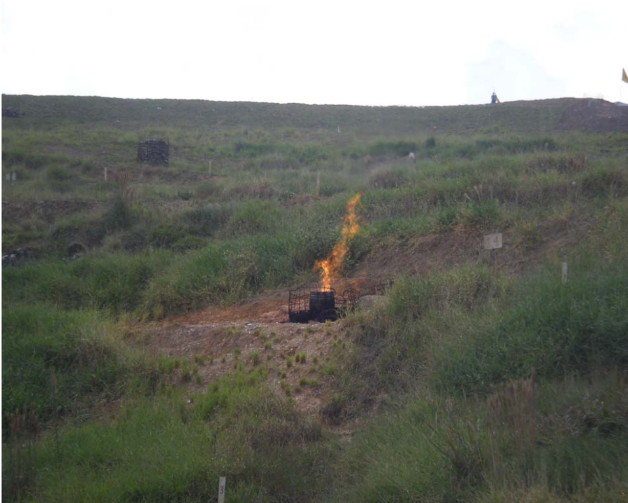
Foto 10 – Queima dos gases no terreno do aterro. Fonte: Arantes, F., 2008.
