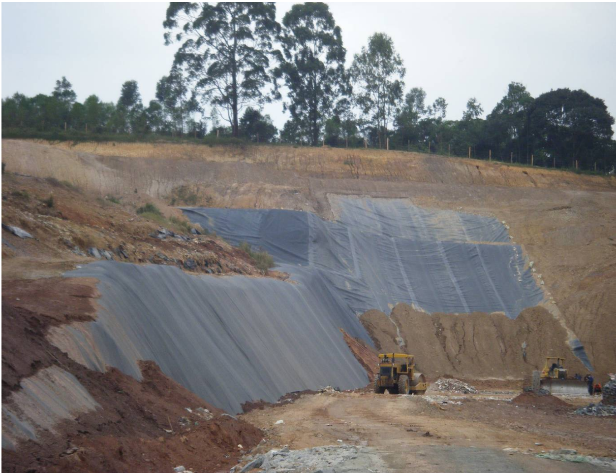
Foto 11 – Taludes cobertos com Geomembranas de Polietileno. Fonte: Arantes, F., 2008.
