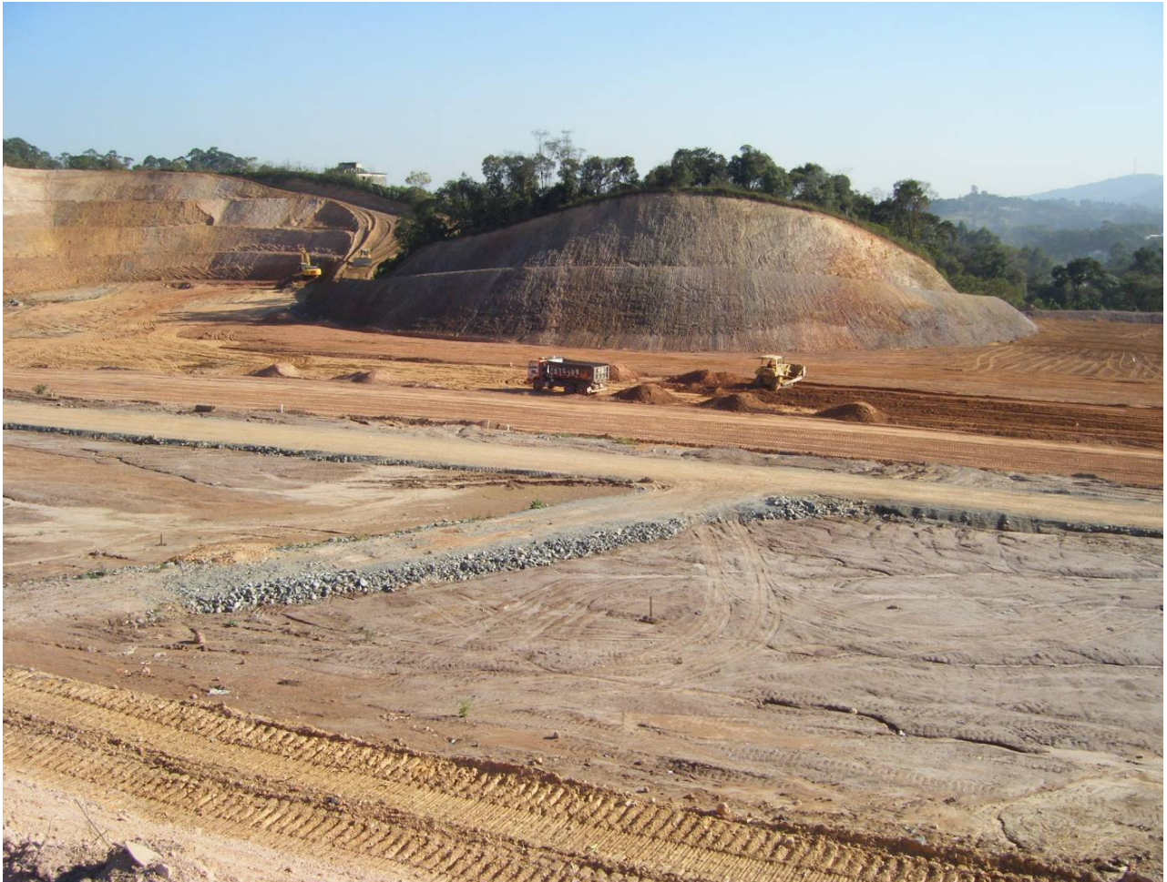
Foto 16 – Área de ampliação para disposição dos RSD. Fonte: Arantes, F., 2008.
