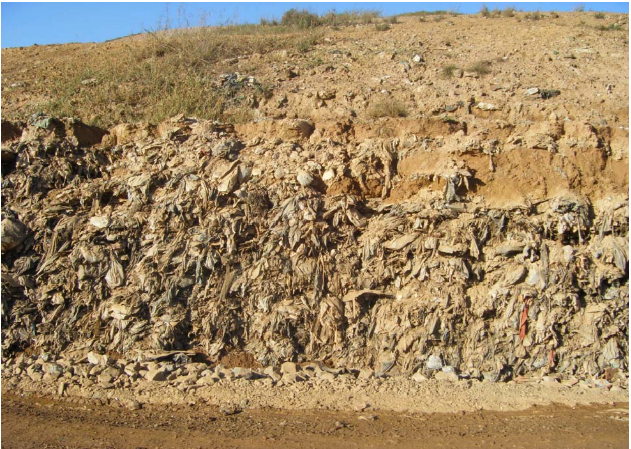
Foto 18 – Processo erosivo no terreno e a massa do lixo exposta. Fonte: Arantes, F., 2008.
