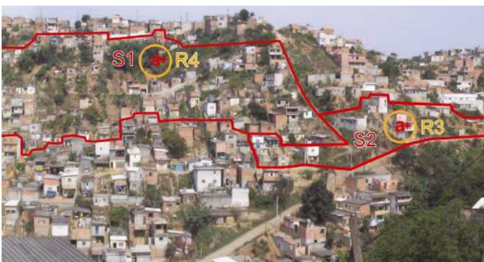
FIGURA 41 – VISTA PARCIAL DOS SETORES 1 E 2, NO TALUDE A JUSANTE DA RUA PALMIRA ROSSI
